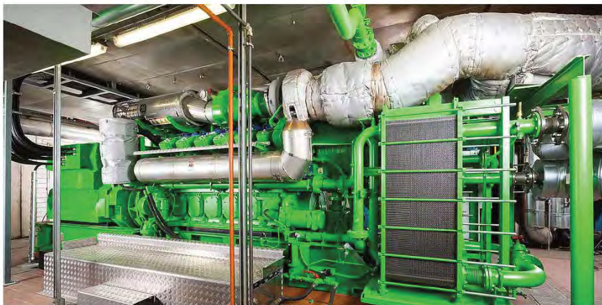
Die Wärmeversorgung in Schwäbisch Hall wird über vier Blockheizkraftwerke sichergestellt, die in Kraft-Wärme-Kopplung betrieben werden. Das Bild zeigt den Motor des Heizkraftwerks Teurershof.
