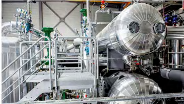
142 Tonnen schwer – die größte Flusswärmepumpe Deutschlands in Mannheim Foto: Markus Prosswitz
