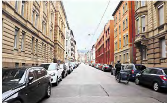
Eine Vielzahl unzureichend sanierter Altbauten findet man auch im Stuttgarter Westen.
